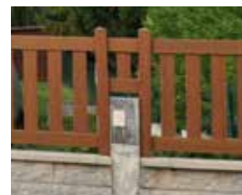
Clôture en bois
