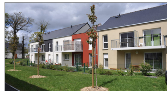
Logements semi-collectifs (35580 Guichen, Atelier du canal)
