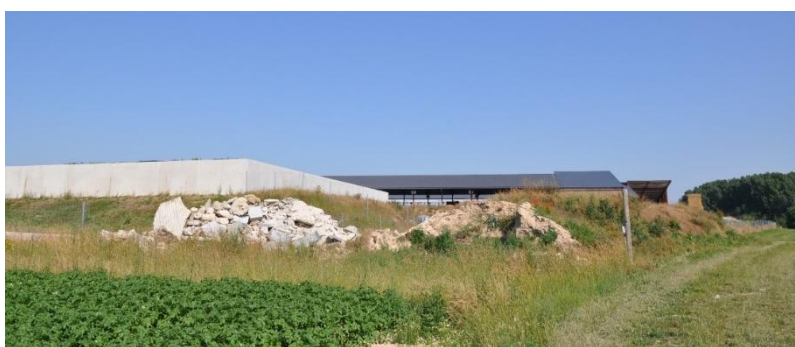
Figure 5 : Vue sur le méthaniseur depuis la route départementale RD4, Faux-Vésigneul. Crédit photo : AUDC
