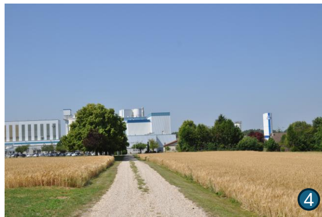
Vue sur la rue du Stade et le site industriel d'Omya, au sud-ouest du site d'OAP.
