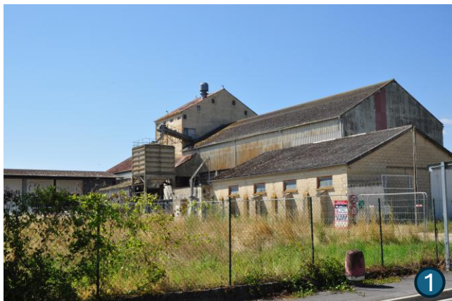
Vue sur le silo avant la démolition et la dépollution du site.
